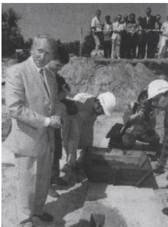
Fot. 4 Podsekretarz Stanu, Kazimierz Dera, w trakcie wmurowywania aktu erekcyjnego
